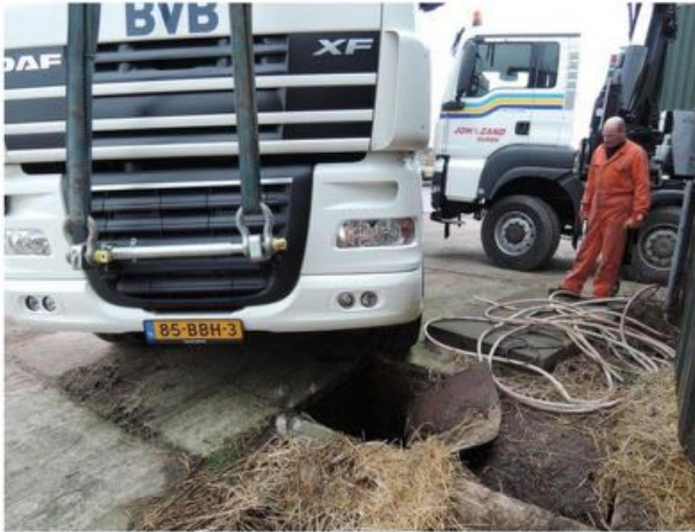
Hisser avec une grue
